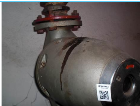
Matériaux : ZPSO-D06 Prélèvement : P278 Description : Joint de bride pompe obus Localisation : RdC - 028 Résultat : Absence d'amiante
