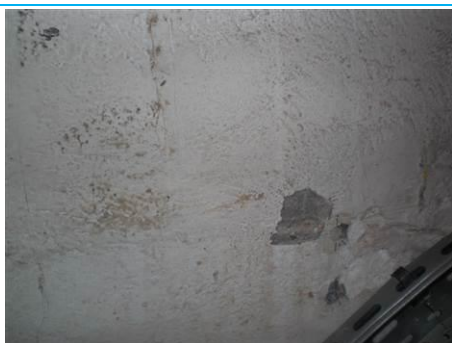
Matériaux : ZPSO-M12 Prélèvement : P274 Description : Enduit ciment refend cloison Localisation : RdC - 028 Résultat : Absence d'amiante
