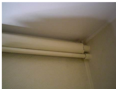
Matériaux : ZPSO-D04 Prélèvement : P247; P256 Description : Enveloppe et calorifuge cartonné Localisation : R1 - 014; R1 - 011; R1 - 007; R1 - 006; R1 - 005; R1 - 008; R1 - 012; R1 - 017; R1 - 020; R1 - 022; R1 - 023; R1 - 021; R1 - 016 Résultat : Présence d'amiante Quantité : 57
