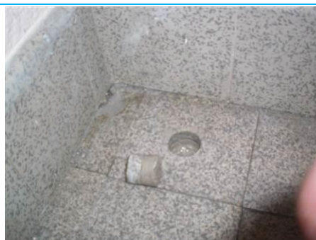
Matériaux : ZPSO-S13 Prélèvement : P261; P270 Description : Colle de carrelage grès cérame 10*10 gris Localisation : R1 - 015; R1 - 018; R1 - 024; R1 - 032; R1 - 019 Résultat : Absence d'amiante Quantité :
