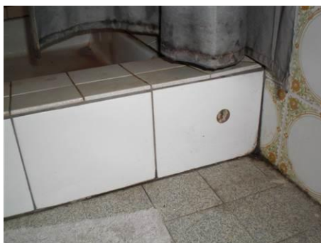
Matériaux : ZPSO-F07 Prélèvement : P253 Description : Colle de plinthe receveur 20*20 blanche Localisation : R1 - 015 Résultat : Absence d'amiante
