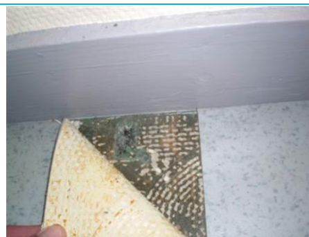
Matériaux : ZPSO-S14 Prélèvement : P257; P269 Description : Dalle de sol 22*22 verte et colle noire sous dalles souples 33*33 Localisation : R1 - 017; R1 - 018b; R1 - 034; R1 - 020; R1 - 022; R1 - 024b; R1 - 033; R1 - 026; R1 - 027; R1 - 021; R1 - 019b; R1 - 031; R1 - 016 Résultat : Présence d'amiante
