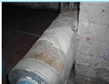
Matériaux : ZPSO-D05 Prélèvement : P276; P277 Description : Enveloppe plâtre et calorifuge Localisation : RdC - 028 Résultat : Absence d'amiante
