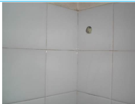
Matériaux : ZPSO-F09 Prélèvement : P233 Description : Colle de faïence 15*15 blanche Localisation : RdC - 025 Résultat : Présence d'amiante
