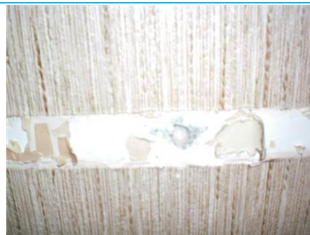
Matériaux : ZPSO-M05 Prélèvement : P220 Description : Enduit plâtre sur cloisons Localisation : RdC - 041; RdC - 040; RdC - 015; RdC - 014; RdC - 042; RdC - 037; RdC - 038; RdC - 011; RdC - 034; RdC - 010; RdC - 007; RdC - 006; RdC - 003; RdC - 036; RdC - 002; RdC - 001; RdC - 004; RdC - 035; RdC - 005; RdC - 008; RdC - 009; RdC - 033; RdC - 012; RdC - 013; RdC - 039; RdC - 018; RdC - 019b; RdC - 019; RdC - 031; RdC - 022; RdC - 023; RdC - 026b; RdC - 026; RdC - 030; RdC - 027; RdC - 029; RdC - 025; RdC - 024; RdC - 021; RdC - 032; RdC - 020; RdC - 017b; RdC - 017 Résultat : Absence d'amiante Quantité :
