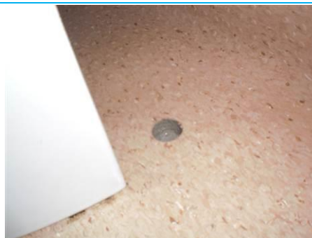
Matériaux : ZPSO-S12 Prélèvement : P245; P249 Description : Colle de carrelage grès cérame gris sous Tarkett douche Localisation : R1 - 039; R1 - 010; R1 - 038; R1 - 003; R1 - 004; R1 - 037; R1 - 009; R1 - 036 Résultat : Absence d'amiante Quantité : m2
