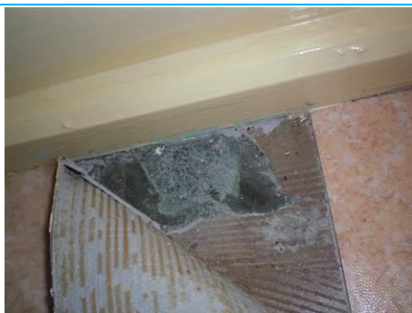
Matériaux : ZPSO-S11 Prélèvement : P244; P248 Description : Dalle de sol 22*22 verte et colle noire sous dalles souples 50*50 Localisation : R1 - 011; R1 - 007; R1 - 006; R1 - 002; R1 - 001; R1 - 005; R1 - 008; R1 - 012; R1 - 013; R1 - 018b; R1 - 034; R1 - 024b; R1 - 033; R1 - 032b; R1 - 025; R1 - 019b; R1 - 031 Résultat : Présence d'amiante Quantité : 150
