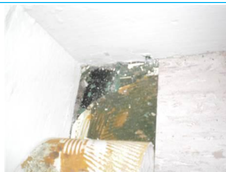
Matériaux : ZPSO-S06 Prélèvement : P228; P234 Description : Dalle de sol 22*22 marron, colle noire et ragréage sous dalles souples Localisation : RdC - 018; RdC - 019b; RdC - 022; RdC - 021 Résultat : Présence d'amiante Quantité : 45
