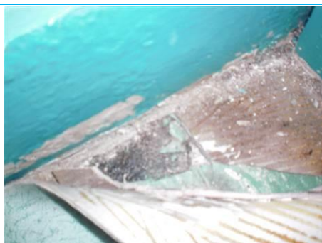
Matériaux : ZPSO-S09 Prélèvement : P235; P238 Description : Dalle de sol 22*22 verte et colle noire sous lés souples Localisation : RdC - 040; R1 - 029; R1 - 028; R1 - 035; R1 - 030 Résultat : Présence d'amiante Quantité : 77
