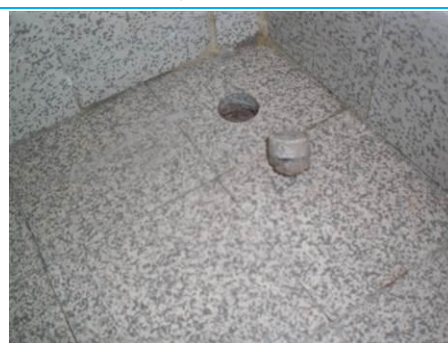
Matériaux : ZPSO-S07 Prélèvement : P224; P231 Description : Colle de carrelage grès cérame 10*10 gris Localisation : RdC - 019; RdC - 026; RdC - 025; RdC - 020 Résultat : Absence d'amiante Quantité :
