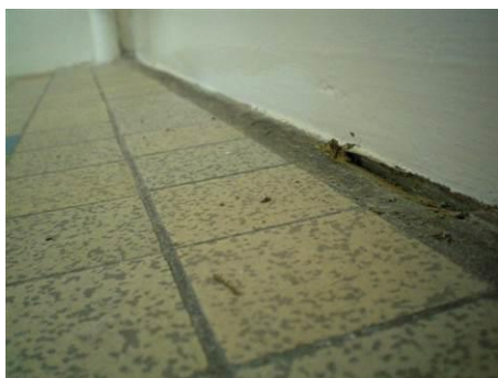
Matériaux : ZPSO-D03 Prélèvement : P242 Description : Joint mastic périmétrique de sol Localisation : R1 - 014 Résultat : Présence d'amiante Quantité : 17
