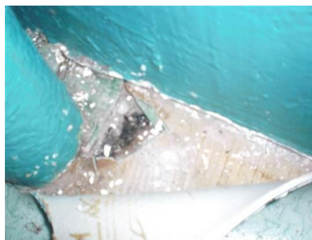
Matériaux : ZPSO-S09 Prélèvement : P235; P238 Description : Dalle de sol 22*22 verte et colle noire sous lés souples Localisation : RdC - 040; R1 - 029; R1 - 028; R1 - 035; R1 - 030 Résultat : Présence d'amiante Quantité : 77
