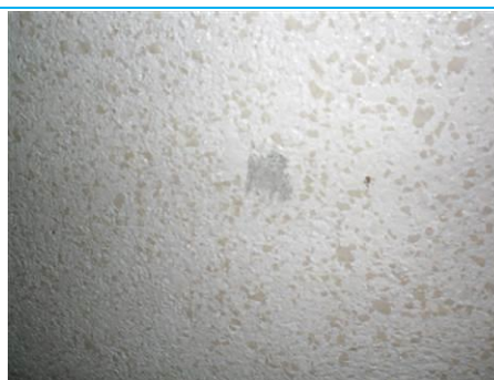
Matériaux : ZPSO-M07 Prélèvement : P237; P240 Description : Peinture pailletée blanc crème sur enduit ciment Localisation : R1 - 035; R1 - 030 Résultat : Absence d'amiante Quantité :
