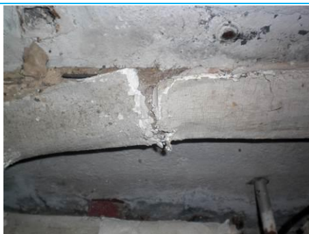
Matériaux : ZPSO-D05 Prélèvement : P276; P277 Description : Enveloppe plâtre et calorifuge Localisation : RdC - 028 Résultat : Absence d'amiante
